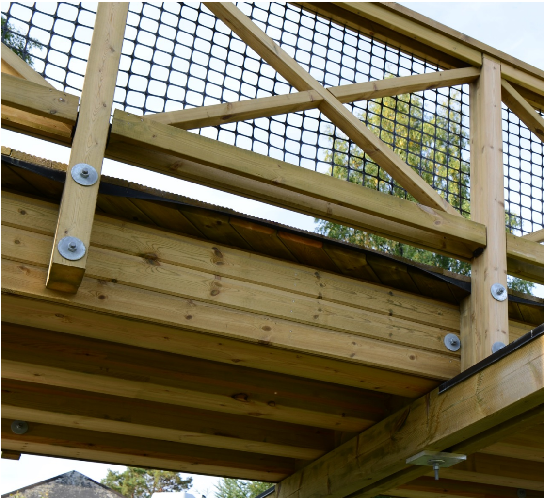
Fig. 3. Exempel på impregnerad panel på balksidor.
