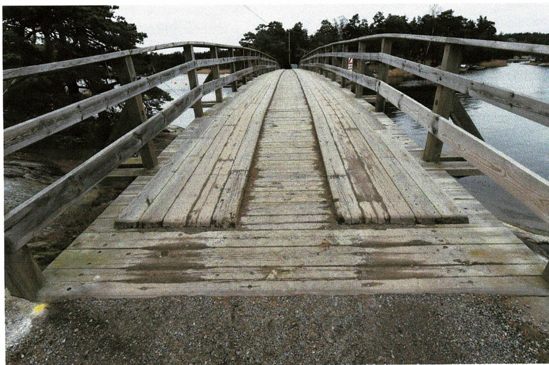
Fig 3. Södra landfästet, stöd 1, med gulmarkerad referenspunkt, Ref. 1.
